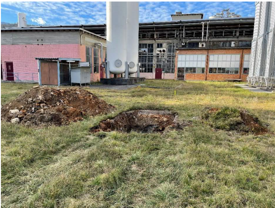
Abbildung 4 Umgebungsfoto Baggerschacht Nr 2 (BS2/22) im Feld 34C
